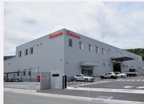
府中第二工場の外観
